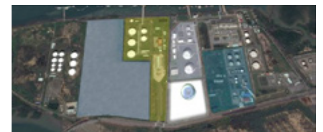
Kho chứa LNG tại Thị Vải
