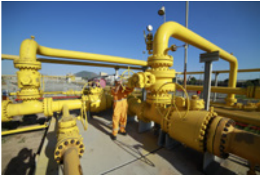
Đường ống dẫn khí
